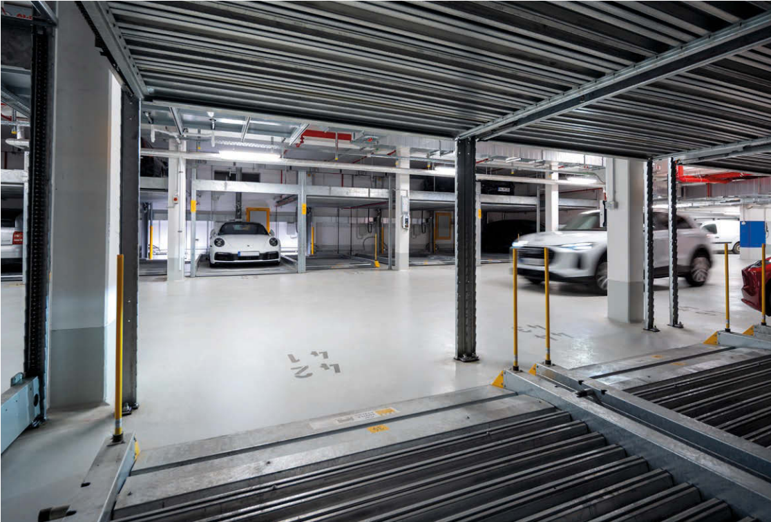
Der Aufbau des Untergeschosses zeigt den Flächenbedarf der Systemlösung im Vergleich zur konventionellen Bauweise für jeweils etwa 50 Stellplätze.
