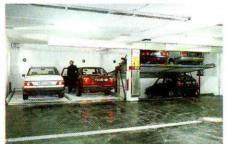
Der Parklift 402 (siehe auch Abb. links unten) benötigt keine Mittelstützen: die Plattformen können bequem über die gesamte Fläche befahren werden.
