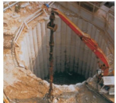
Links sehen Sie einige Varianten verschiedener Stellplatzanordnungen in unterirdischer Bauweise; oben einen zylindrischen Schacht, der für den Einbau eines herkömmlichen LP580 (16 Stellplätze) vorbereitet wurde und darüber eine elliptische Grundrißzeichnung.
