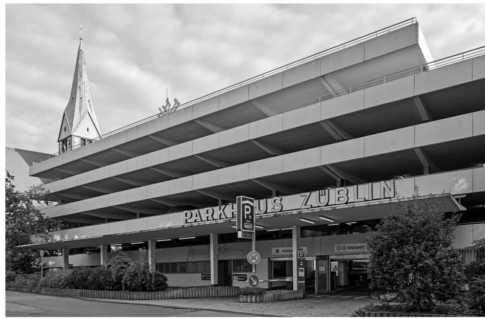
Bestand des Züblin Parkhauses
