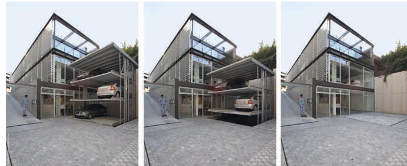
Das Autoparksystem wird unsichtbar in den Boden versenkt, die waagerechten unterirdischen Plattformen sind erst beim Anheben für den Ein- oder Ausparkvorgang sichtbar. Die Deckelplatte kann individuell der Umgebung angepasst werden.
