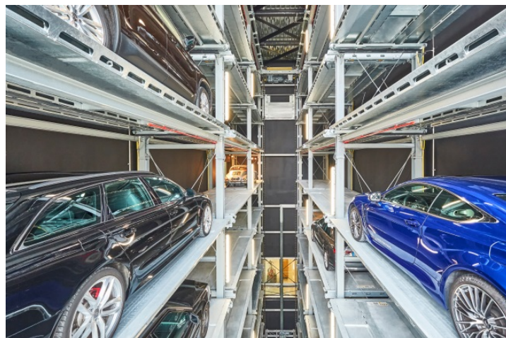
Bild 2: Die Parkpaletten sind dreireihig in Längsrichtung zum Vertikalförderer angeordnet.
