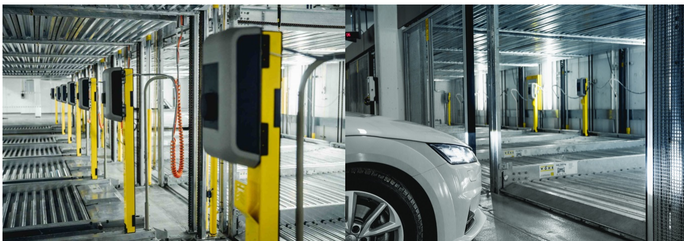
Bild 5 und 6: Die Universal-Standsäule von WÖHR für bauseitige Wallboxen wird standardmäßig auf der Seitenwange befestigt.
