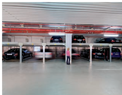
02 | B Die EG-Stellplätze 115 und 113 verschieben sich automatisch nach links.
