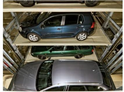
12 Dort wird der Vertikallift positioniert und die Palette wird an eine vorhandene angekuppelt. Vor dem Einschleusen der Paletten ins Lagerfach wird der Vertikallift am Stahlbau verriegelt.
