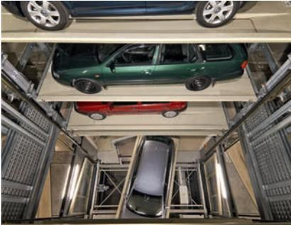
10 Die Palette mit Fahrzeug wird gedreht und angehoben.
