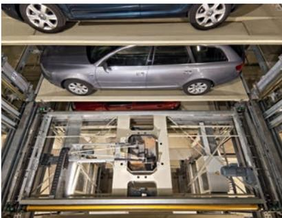
13 Der Lagervorgang ist abgeschlossen, der Vertikallift bringt anschließend eine Leerpallette zur Übergabestation.
