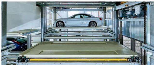
Aufgrund der schwierigen Gebäudesituation werden zwei Systeme zusätzlich mit einem seitlichen Vertikallift ausgerüstet. Über diese werden von der Übergabekabine Autos ein- bzw. ausgelagert.
